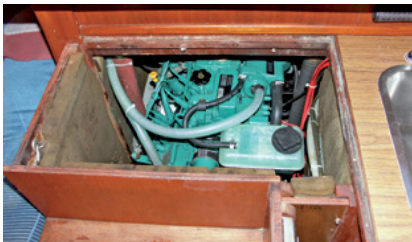
Die Maschine sitzt unter dem Niedergang. Der Zugang ist etwas eng, kann aber durch eine etwas umständliche Demontage der Verkleidung vergrößert werden
